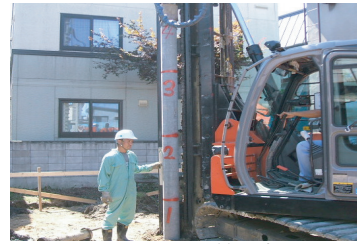
コンクリート杭の打設
