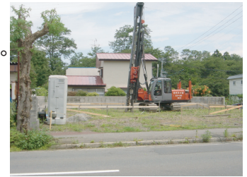
コンクリート杭工事
