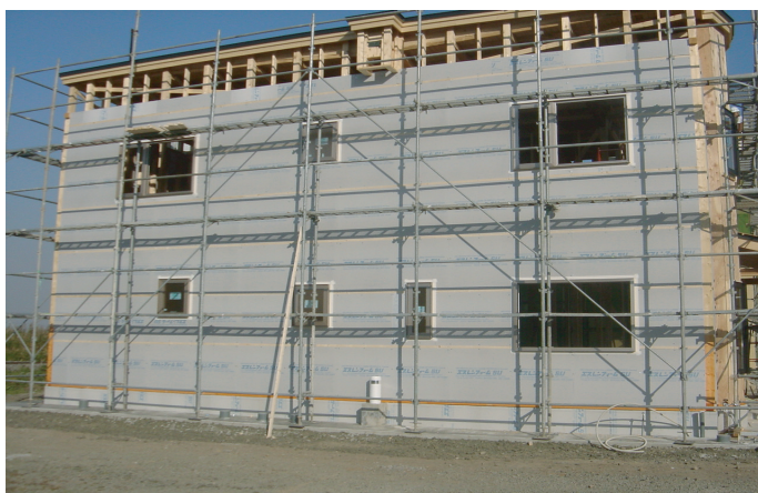
外張断熱材を外部に施工します。
