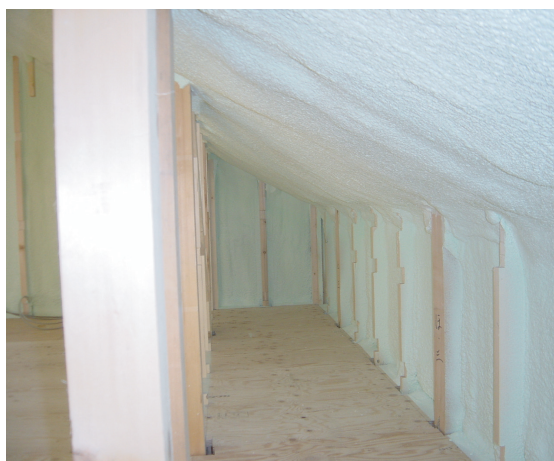
壁から小屋裏断熱へと断熱材が連続しています
