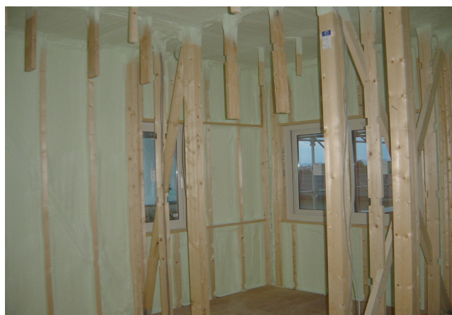
その外張断熱材に現場発泡のウレタンを吹きつけします。
